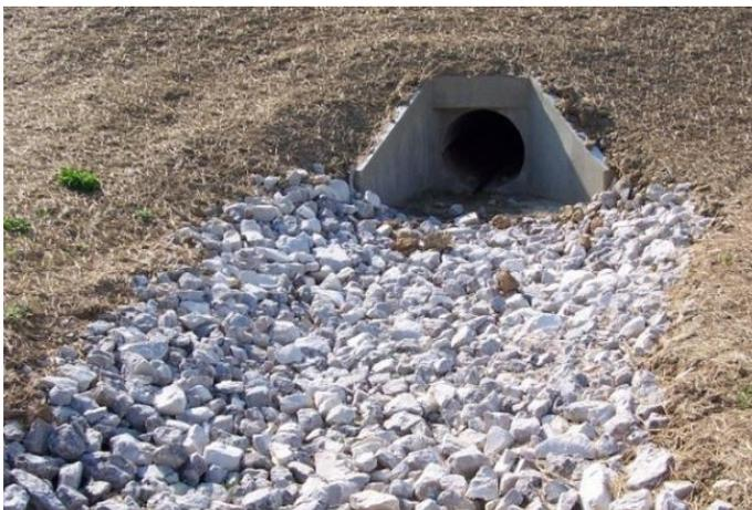
**Figura 8.5 – Exemplo de bacia de dissipação em enrocamento.**
