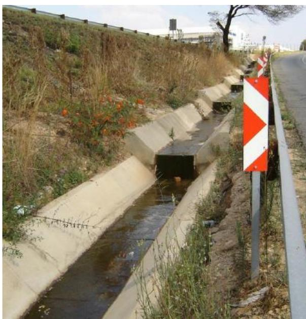
**Figura 8.10 – Degraus para controlo da velocidade em valetas e valas**
