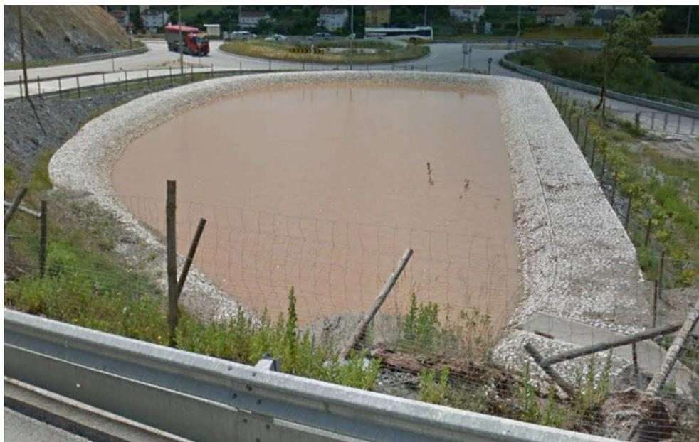
**Figura 8.6 – Exemplo de uma bacia de retenção.**
