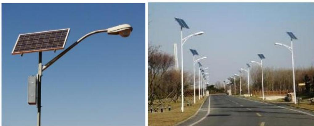
**Figura 8.13 – Iluminação pública através de painéis solares**
